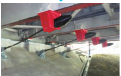
中国道 北房IC～新見IC 下布瀬橋
