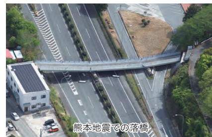
九州道を横架する県道の府領第一橋
