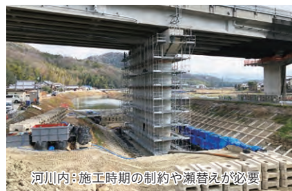
高松道 三豊島坂IC～さぬき豊中IC 高瀬川橋
