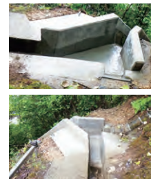
強化後の縦溝と集水ます
